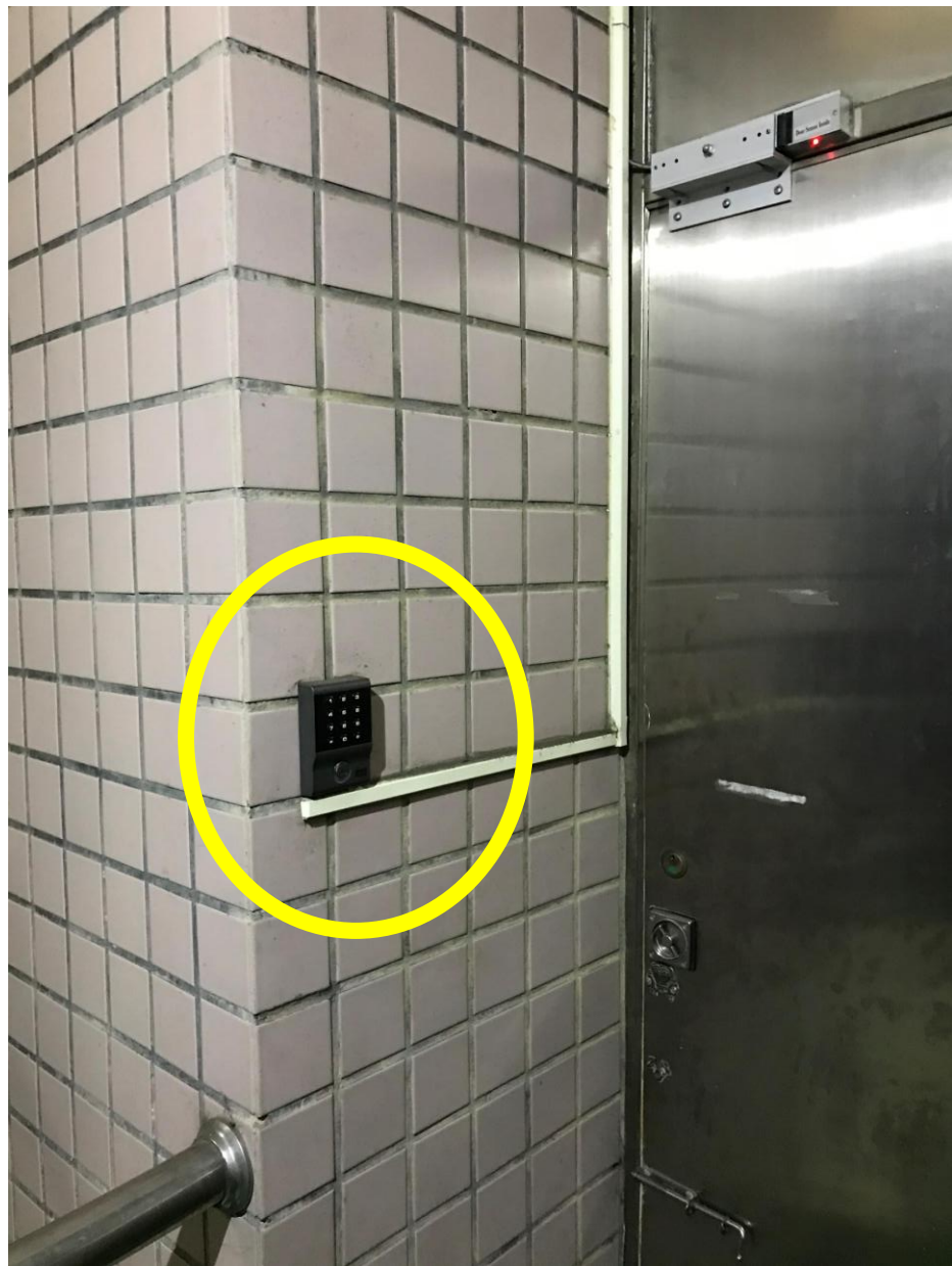
行政大樓地下室
